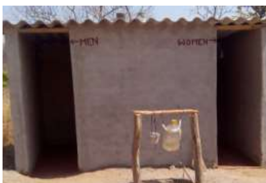
Standard UBVIP toilets
